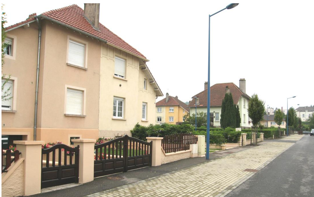
Exemples de clôtures en mur-bahut + claire-voie et/ou haie végétale à la cité Tivoli
