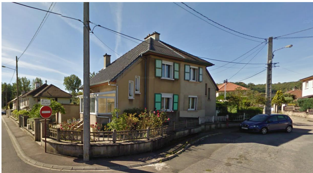
Exemple de clôture à préserver ou à reproduire au Konacker
