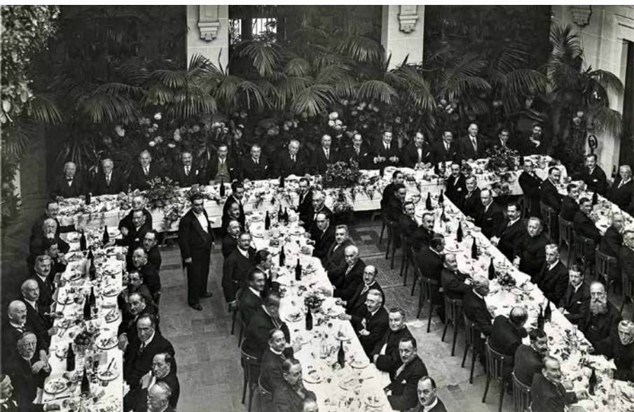
Banquet des cadres des Grands Bureaux organisé dans les années 30 sous la verrière du hall d'entrée. (Archives CAVF)
