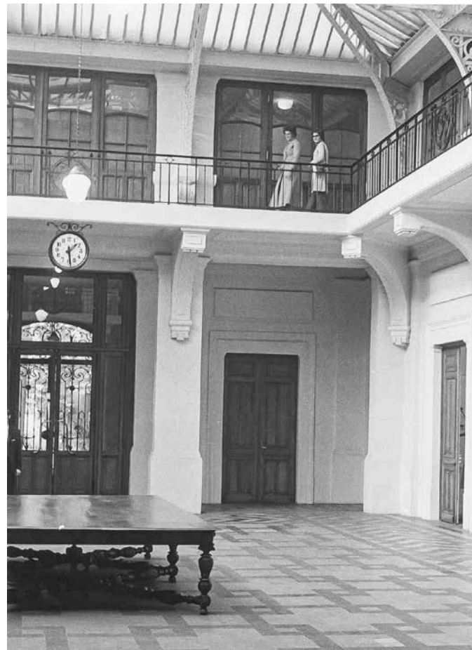
Des employées administratives des Grands Bureaux en 1970, sous la verrière du hall d'entrée. (Archives ArcelorMittal)
